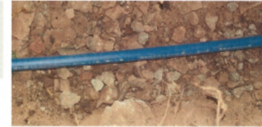
Bild 5: Alternative (sandbettlose) Verlegung eines Rohres
