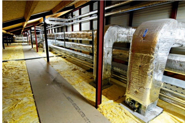
Raumgewinn Sanierung Schule Im unterhalb der Kollektoren entstandenen Dachraum fand die Lüftungsanlage mit Wärmerückgewinnung Platz.
