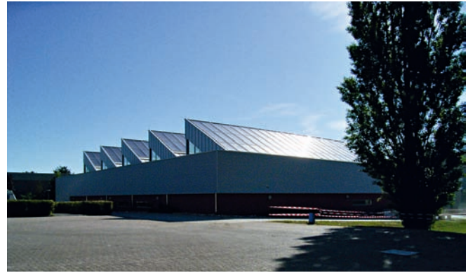
Neubau Sporthalle Das Solardach in Shed-Bauweise sichert auch die Versorgung mit Tageslicht auf dem Spielfeld der Sporthalle.
